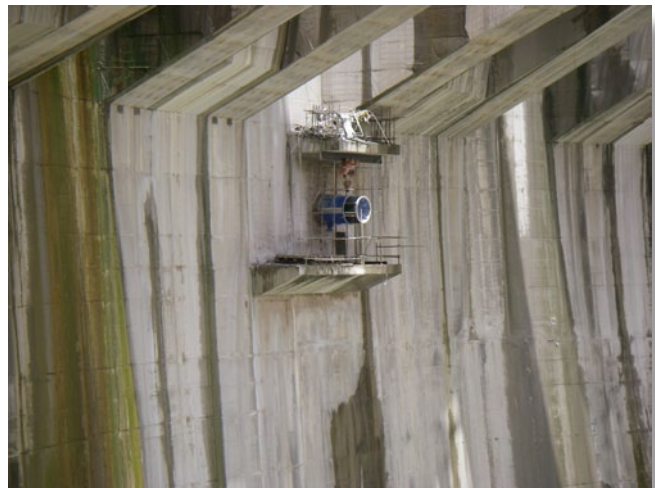
Выпускной струйный клапан VAG KSS
