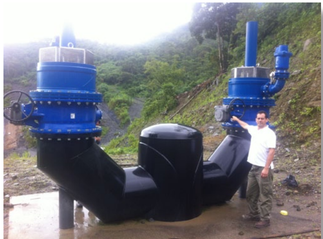
VAG EKN® Поворотный затвор DN 800 и VAG Пружинный воздушный клапан DN 800
