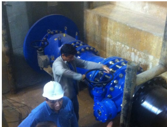
VAG RIKO® Плунжерный клапан DN 500 за VAG EKN® Поворотным затвором во время проверки
