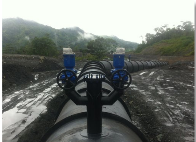
VAG DUOJET® Автоматический воздушный клапан DN 200 и VAG EKO®plus Клиновая задвижка DN 200
