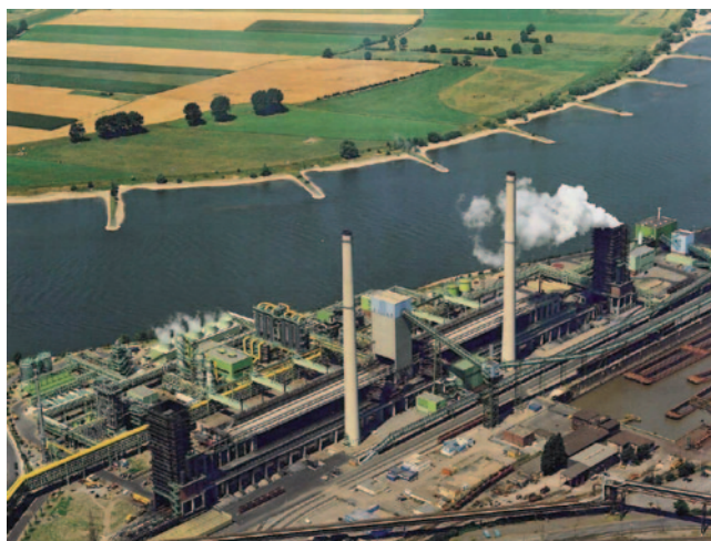
Новый коксохимический завод Швельгерн с двумя коксовыми печами
