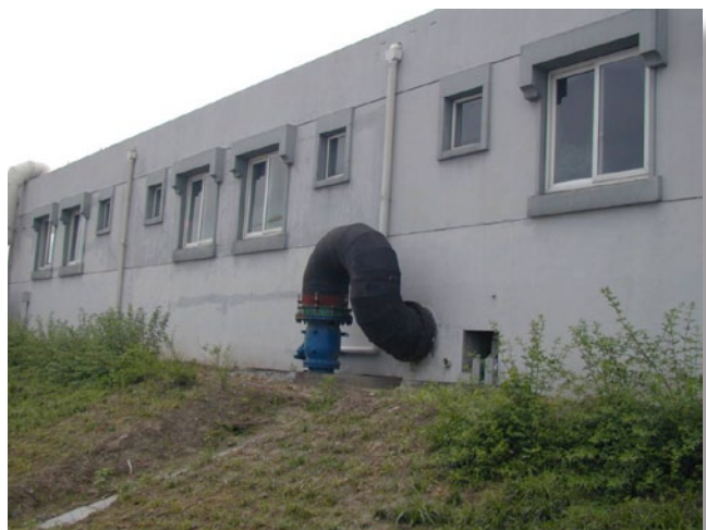
Административное здание и вход на территорию очистных сооружений Hangzhou Qi Ge
