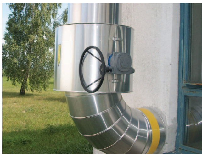
Изолированный Поворотный затвор VAG EKN® на подающем трубопроводе
