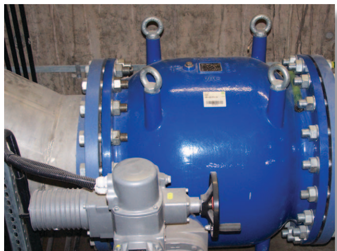
Плунжерный регулирующий клапан VAG RIKO®
