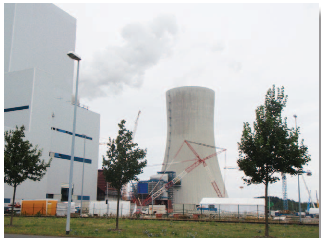
Строительство Блока R, работающего на буром угле
