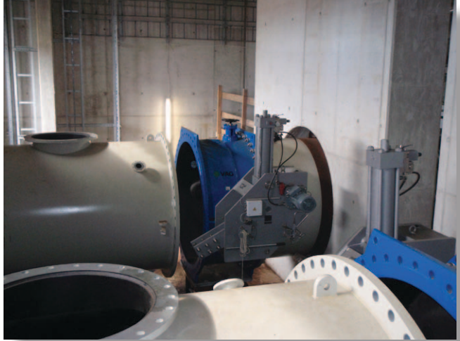
Монтаж поворотно-го затвора VAG EKN® с двусторонним блокирующим устройством UVV
