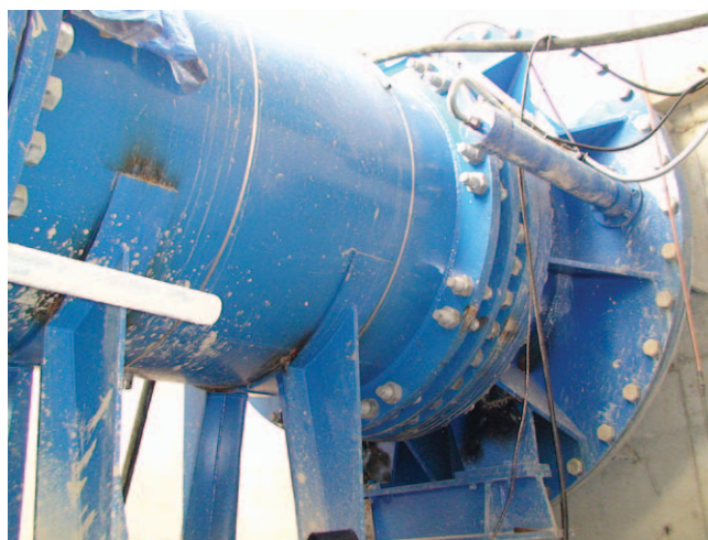
Установленный затвор VAG KSS
