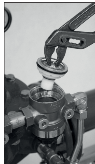
Obr. 45: Vyjmutí vnitřní vložky
