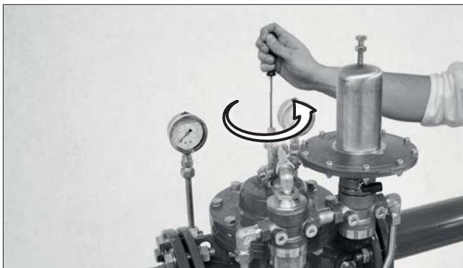
Obr. 34: Odvzdušnění ventilu
