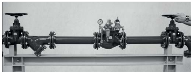
Obr. 11: Částečné otevření uzavírací armatury za ventilem
