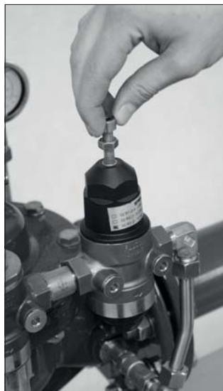
Obr. 42: Uvolnění kontramatice
