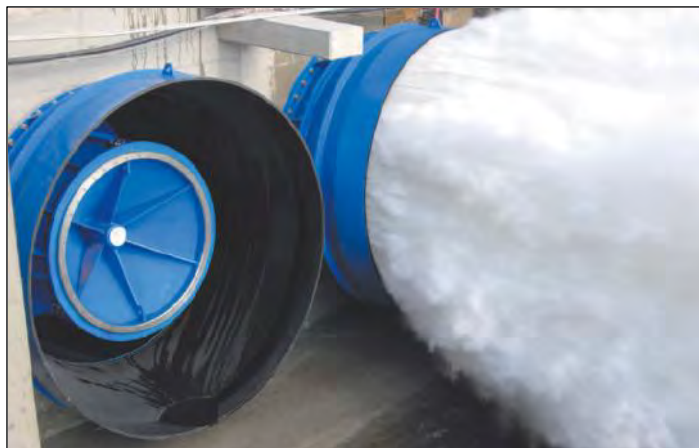
Obr. 3 Ventil s integrovaným zavzdušňovacím systémem a usměrňovacím difuzorem výtoku
