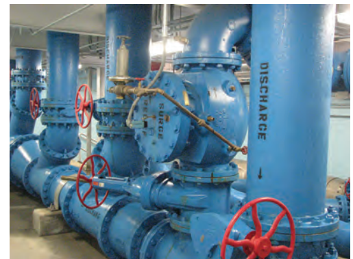
Das GA Druckstoßentlastungsventil DN 300 (12")
