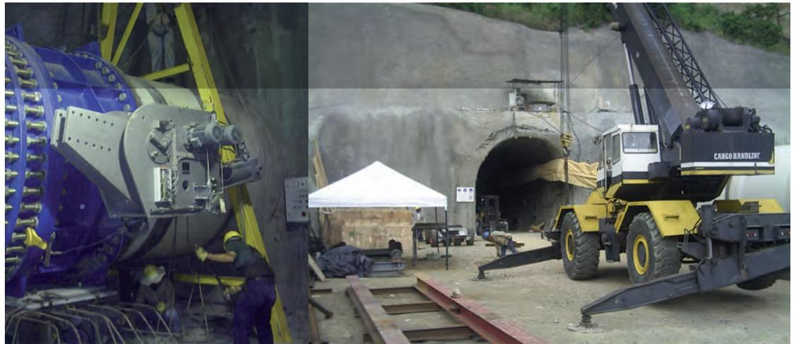
Im Januar 2006 begannen die Bauarbeiten zu dem weitreichenden Projekt: Über 1,5 Tonnen Sprengstoff wurden benötigt, um 3.500 Meter Tunnel für die unterirdischen Versorgungswege und Armaturen-kammern zu schaffen.
