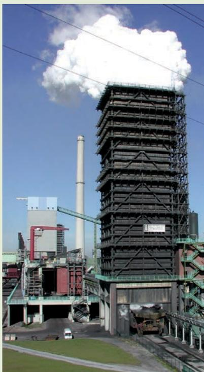
Die Koksrohle wird nach einer Garzeit von 25 Stunden glühend aus den Öfen in den bereitstehenden Löschwagen geschoben. Dieser fährt den Koks anschließend unter den Löschurm, wo er in 70 Sekunden mit über 100 m<sup>3</sup> Löschwasser abgelöscht wird. Dieser Vorgang wiederholt sich alle 10 Minuten, also 135 mal pro Tag, 7 Tage die Woche, das ganze Jahr hindurch.
