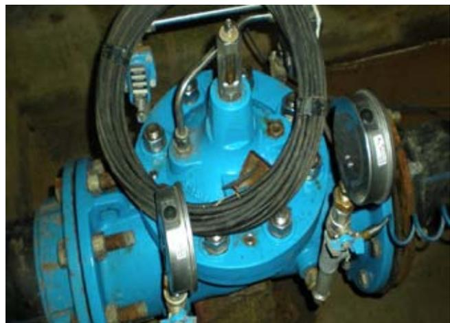
VAG PILOT Válvula de membrana
