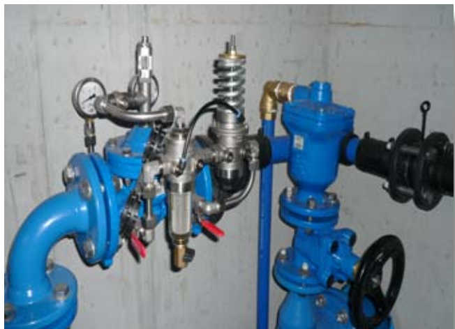
Vanne de régulation VAG PICO® comme vanne de sécurité avec ventouse triple fonction VAG BEV
