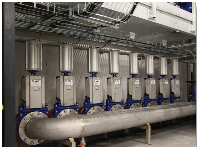
Instalación debajo del pabellón
