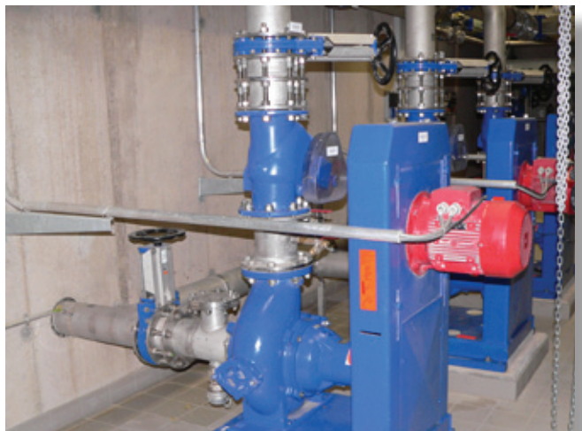
Armaturen im Einbau
