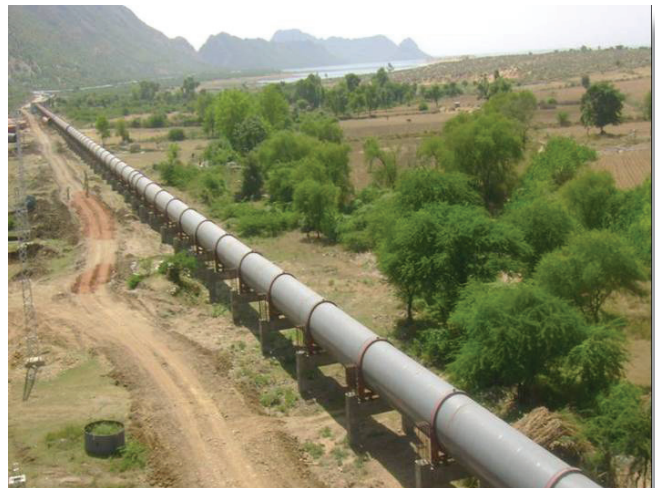
Conducto de abastecimiento de agua
