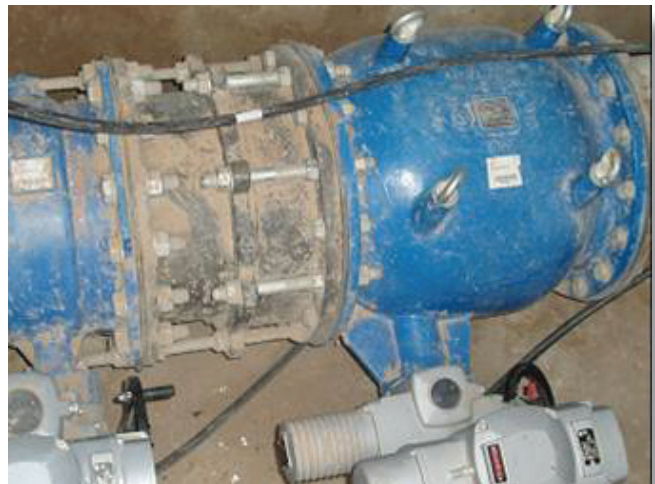
VAG RIKO® Válvula de paso anular
