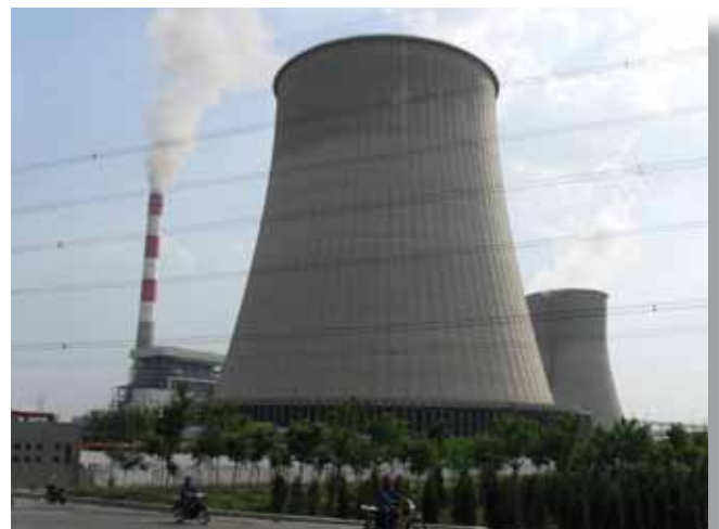
Torres de enfriamiento secas en la termoeléctrica Yangcheng
