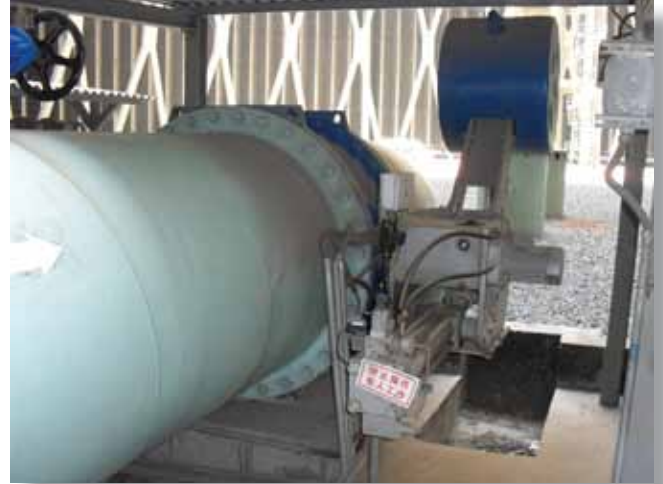
Válvula de mariposa VAG EKN® con accionamiento de contrapeso hidráulico VAG HYsec en posición abierta
