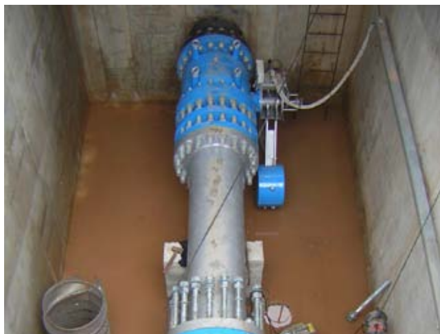
Conduites de distribution d'eau avec vanne annulaire VAG RIKO® à entraînement par levier/contreponds et frein hydraulique
