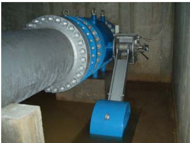
VAG RIKO® Vanne annulaire à entraînement par levier/contreponds et frein hydraulique DN 600 PN 100
