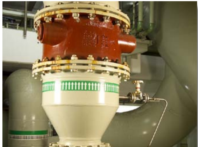
Válvula de retención de asiento inclinado VAG SKR de DN 600 y PN 10 en el tratamiento de agua
