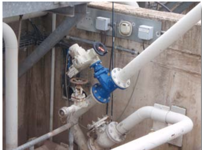
Válvula de compuerta VAG BETA® 300 de DN 100 y PN 16 Uso en el tanque de separación de cenizas
