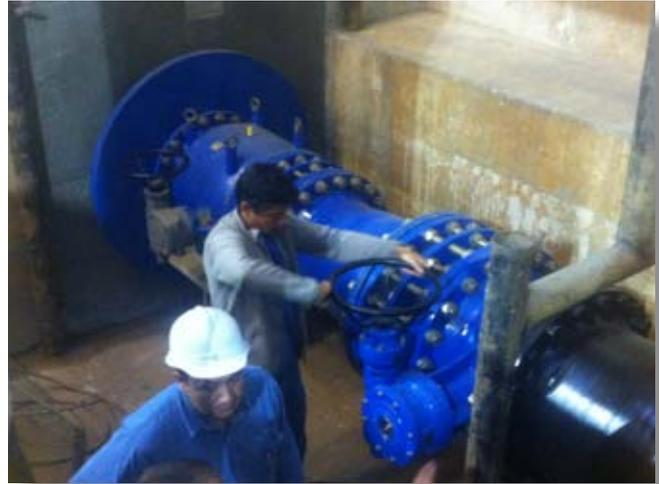
VAG RIKO® Válvula de paso anular DN 500 instalada y junto a ella una VAG EKN® Válvula de mariposa durante la inspección
