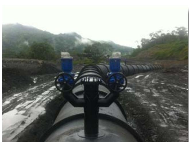
VAG DUOJET® Ventosas automáticas DN 200 y EKO®*plus* Válvula de compuerta DN 200
