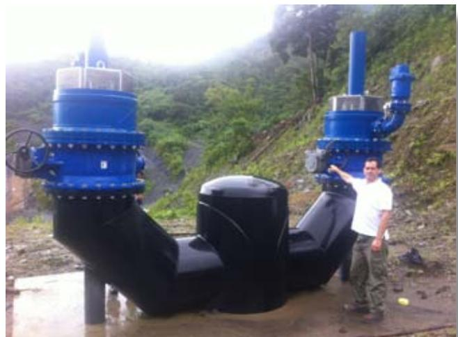
VAG EKN® Válvula de mariposa DN 800 con VAG Ventosas tensionadas por muelle DN 800
