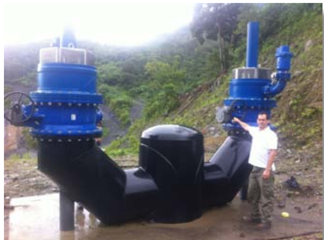
VAG EKN® Absperrklappen DN 800 mit VAG Teller Be- und Entlüftungsventilen DN 800
