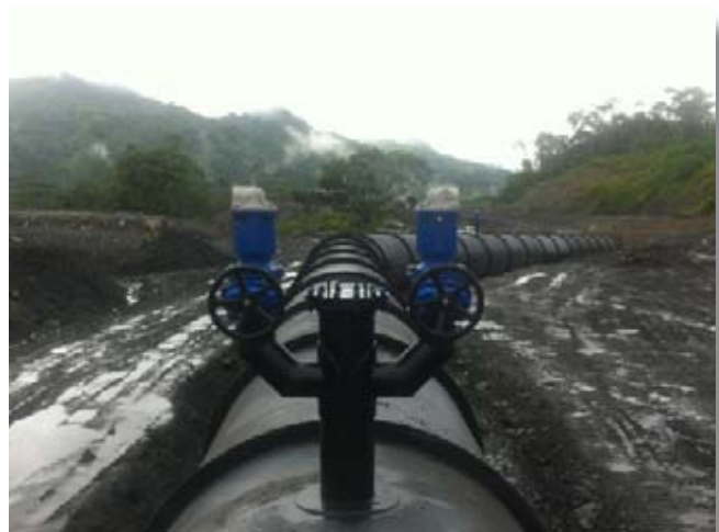
VAG DUOJET® Be- und Entlüftungsventile DN 200 und VAG VAG BETA® 300 Absperrschieber DN 200
