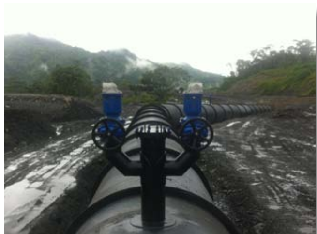
VAG DUOJET® Ventouse triple fonction de DN 200 et VAG EKO® plus Vanne à opercule de DN 200
