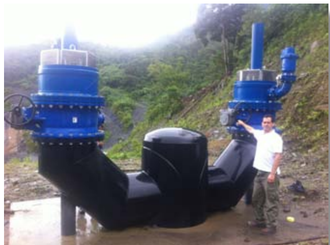
VAG EKN® Vanne-papillon DN 800 avec VAG Ventouses triple fonction DN 800 à siège plan
