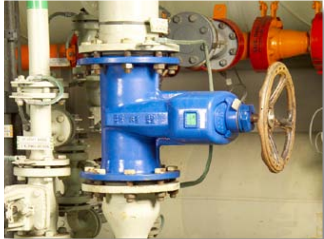
Válvula de compuerta VAG BETA® 200
