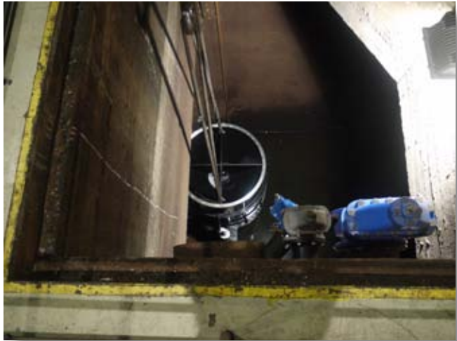
Transport des VAG KSS Kegelstrahlschiebers durch den gefluteten Tunnel
