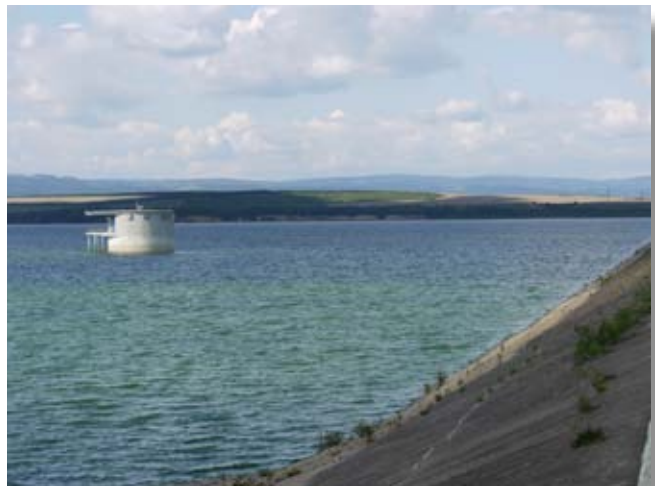
Turbinenturm abseits des eigentlichen Damms
