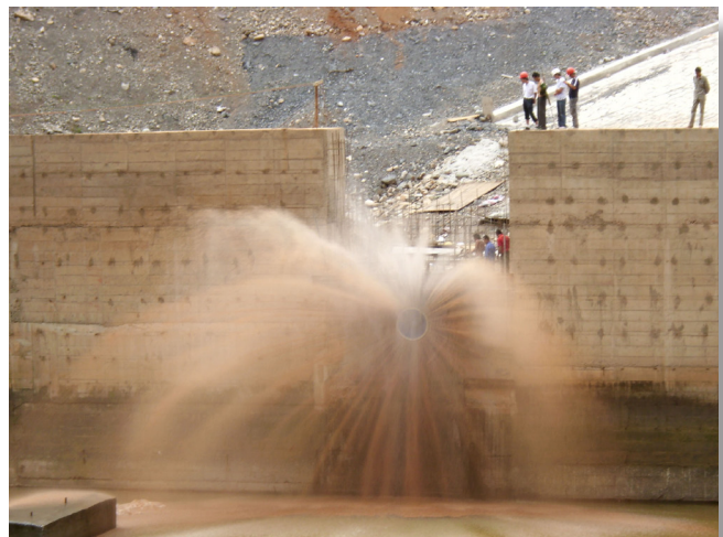
Represa después de la puesta en servicio
