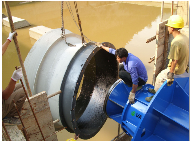
Armatur im Einbau
