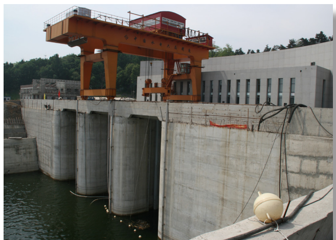
Réservoir d'eau de « Da Huo Fang »
