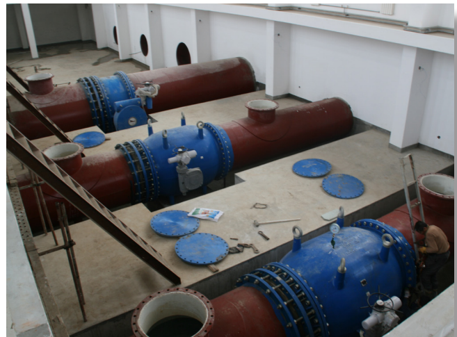
Vannes annulaires VAG montées
