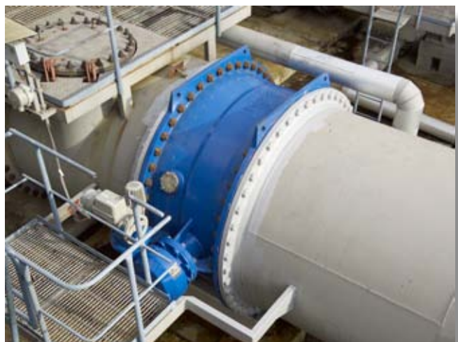
Válvula de mariposa VAG EKN® con bloqueo UVV unilateral
