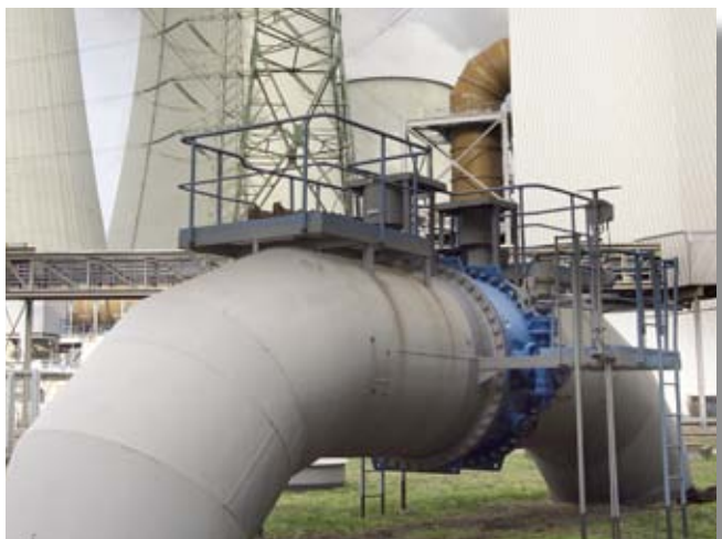
Válvula de mariposa VAG EKN® con bloqueo UVV bilateral como válvula de separación de bloque DN 2000
