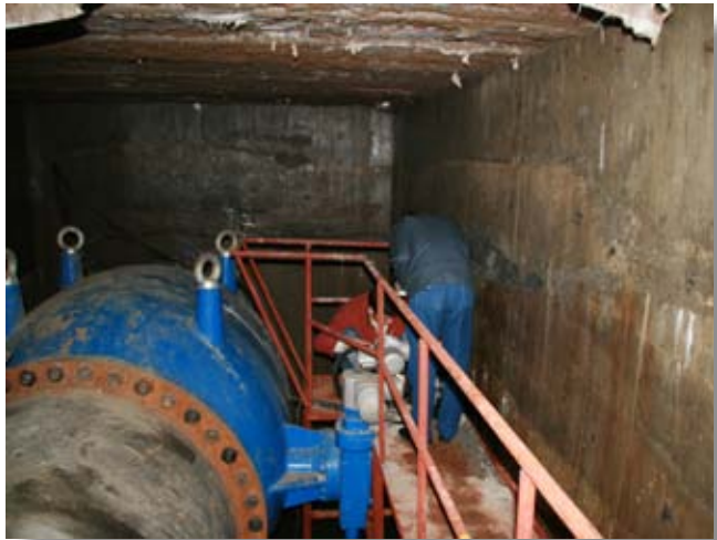
Mise en service d'une vanne annulaire VAG
