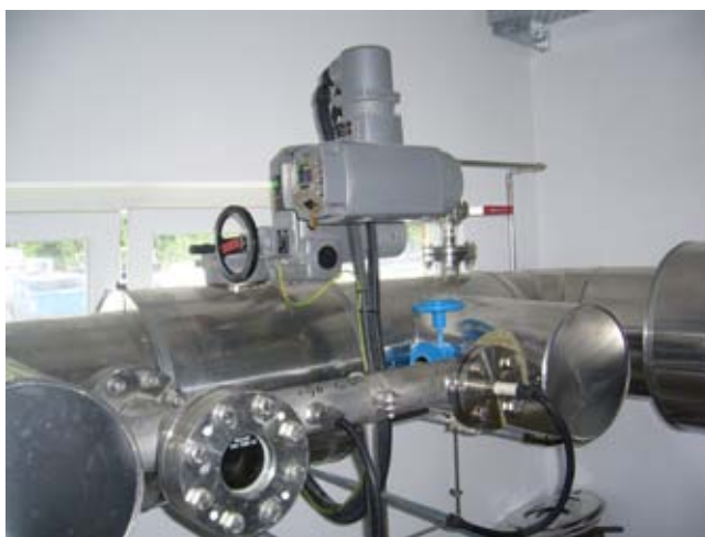
Válvulas de paso anular VAG RIKO® aisladas cada una completamente en la tubería
