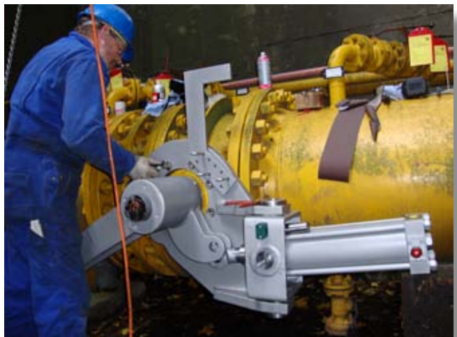
Neu eingebauter hydraulischer Fallgewichtsantrieb
