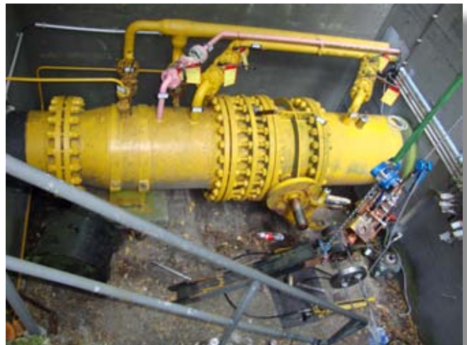
La válvula de mariposa VAG EKN® antes de la reforma
