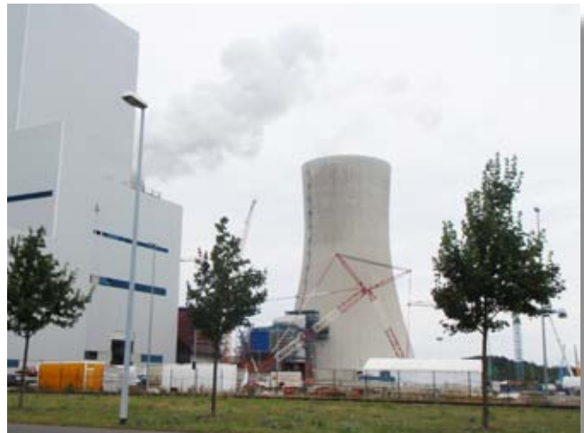
Lugar de obras completa del bloque de lignito R
