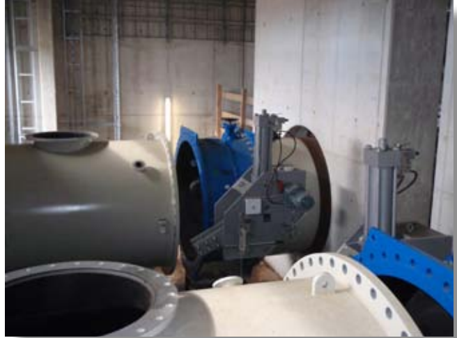
Instalación de una válvula de mariposa VAG EKN® con bloqueo UVV bilateral, lista para el montaje en el sistema de tuberías
