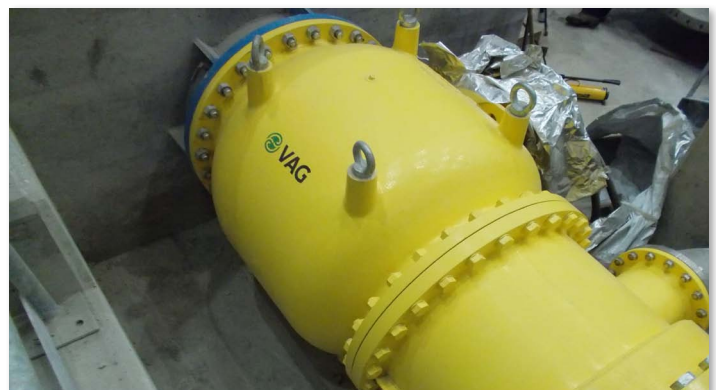
Puesta en servicio de las válvulas de paso anular RIKO® con dispositivo de aireación
