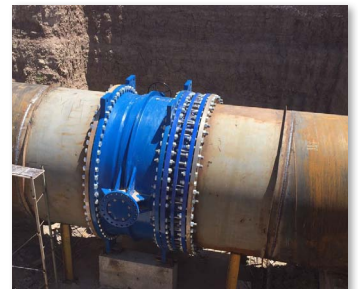
Trabajos finales de instalación de las válvulas de mariposa EKN® en los conductos de transporte de agua
