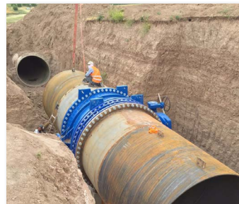
Trabajos finales de instalación de las válvulas de mariposa EKN® en los conductos de transporte de agua
