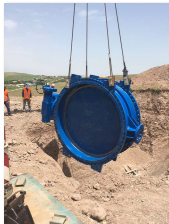
Posicionamiento de las válvulas de mariposa EKN® en las fosas de conducción mediante grúas
