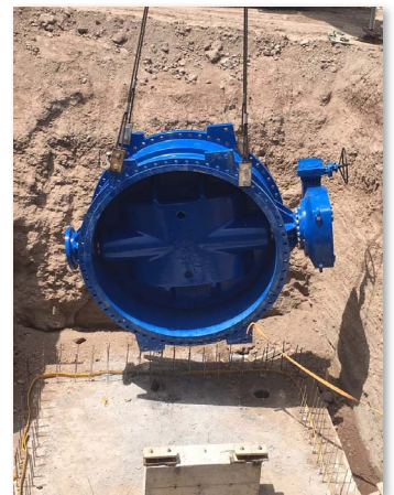
Posicionamiento de las válvulas de mariposa EKN® en las fosas de conducción mediante grúas
