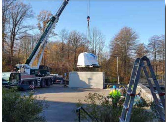
Le poids de la vanne a pu être réduit à 15 tonnes grâce à une construction spéciale.
