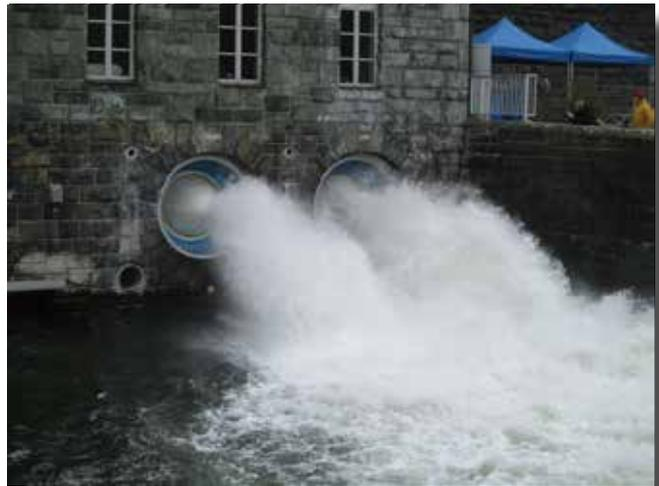
Les nouvelles vannes de décharge par le fond en action
