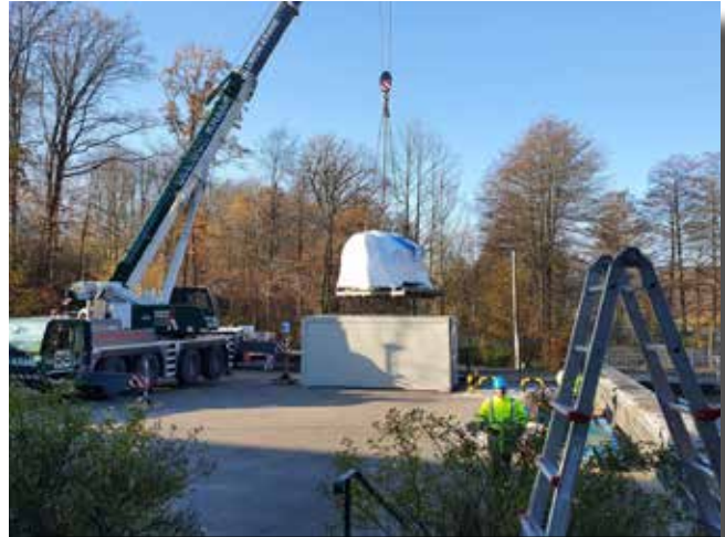
El peso de la válvula se redujo a 15 toneladas gracias a un diseño especial.
