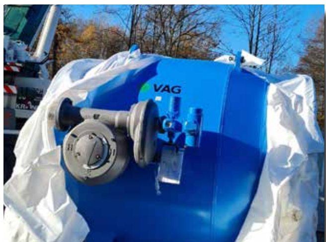
Entrega de las válvulas de paso anulares grandes
