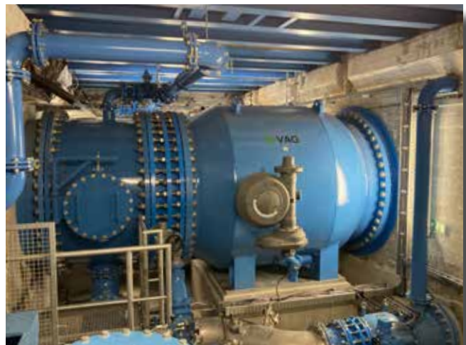
Válvula de paso anular VAG RIKO® DN 2000 incorporada
