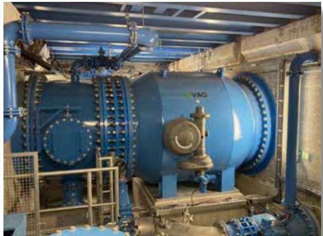
Eingebautes VAG RIKO® Ringkolbenventil DN 2000
