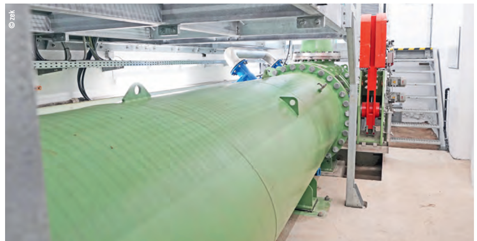
Jede Menge technisches Know-how steckt im Zwischenrohr in der Apparatekammer, am Übergang der alten zur neuen Druckrohrleitung. Das Konzept und auch die Montage in der Schieberkammer wurden vom Team EFG realisiert.
