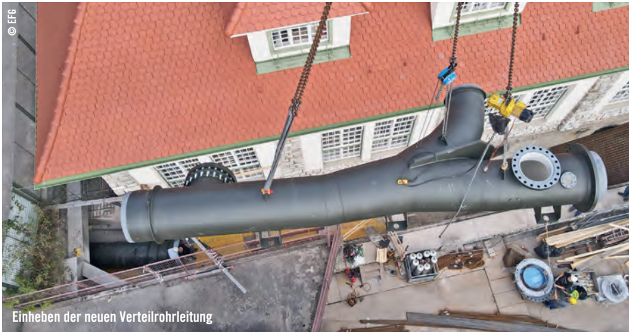
Der neue Grundablass-Ringkolbenschieber DN1000 mit vorgelagertem Absperrorgan wurde von der Firma VAG geliefert und von der Firma EFG montiert.
