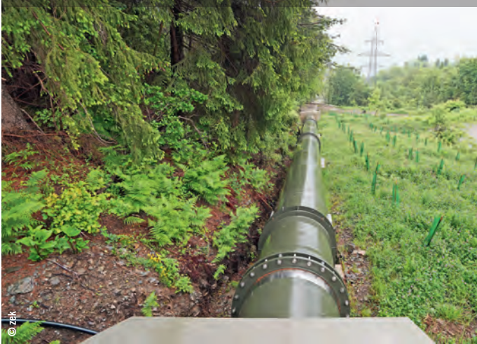
Der rund 335 m lange, oberirdische Teil der Druckrohrleitung wurde mittels einer Stahlrohrleitung DN1200 erneuert. Um eventueller Längendilatation entgegenzuwirken, wurden an den Fixpunkten vier Stopfbuchsen installiert.
