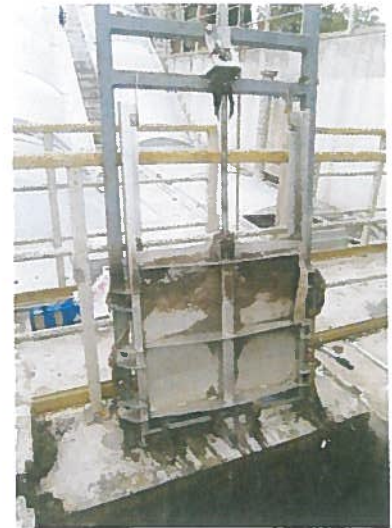
Bild 11: Testeinbau eines VAG EROX®plus Spindelschiebers auf Hilfsrahmen montiert
