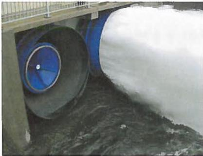
**Bild 3:** VAG KSS Kegelstrahlschieber DN 1 800 mit Strahlführungsrohr (Durchmesser 3 600 mm) im Einsatz
