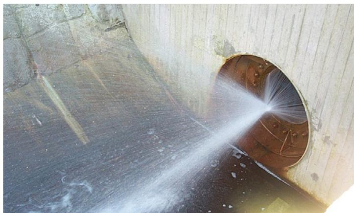
**Bild 6:** Konzentrischer Energieabbau direkt hinter dem Ventil
