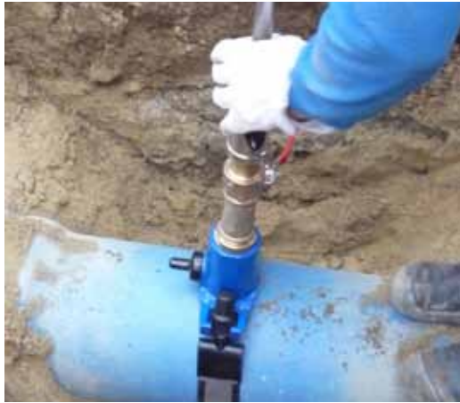
Regensburg, Deutschland VAG TERRA ® lock Anbohrbrücken
